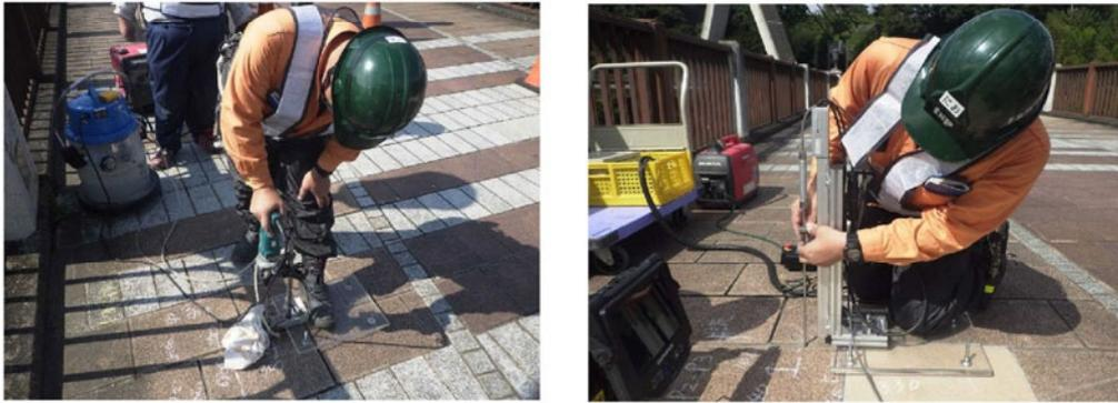
写真-2.2 水平ひびわれ調査状況
