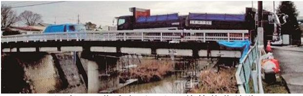
写真-4 荷重車両による静的载荷試験
