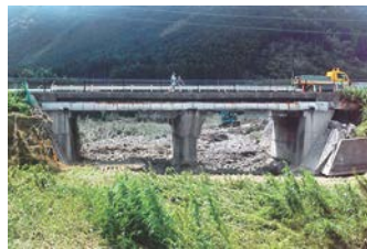
写真-1 大宮第二避溢橋全景
