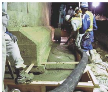
写真-3 コンクリート充填状況
