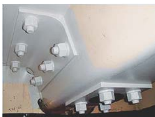
写真-2 き裂部の当て板補強の施工状況
