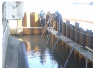
写真-3 流動化処理土工
