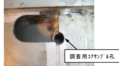
図-6 横梁ウェブ上端のスカラップ施工
