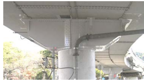
図-5 ブラケット補強 (P15橋脚)
