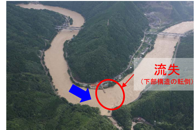
近年発生した大きな洗掘被害
