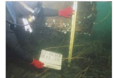
水中部の詳細な調査が可能
