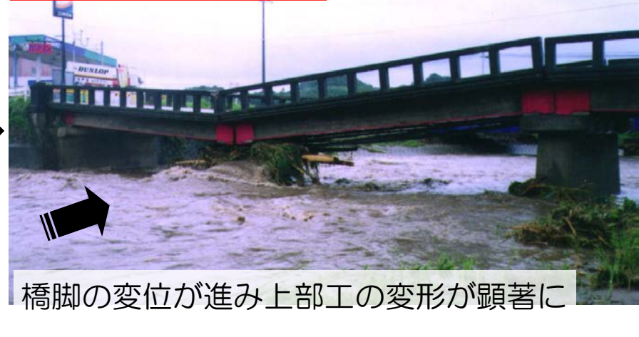
④ 橋脚の傾斜進行， 桁の折れ曲がり
