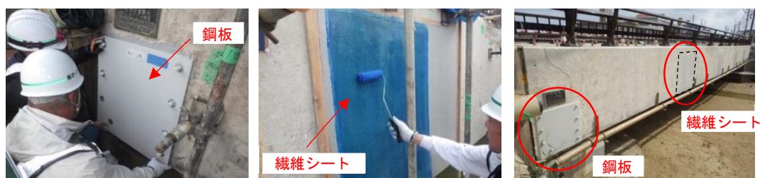
写真 2.3 横締め PC 鋼材の突出防止対策
