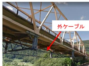
鋼橋の外ケーブル補強の例
