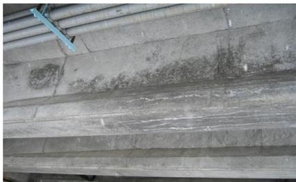
※写真はPC桁下面のひびわれ事例
