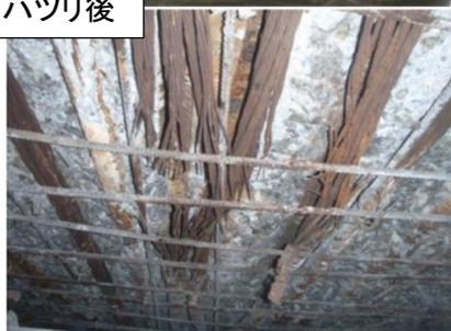
※写真はPC桁下面のひびわれ事例
