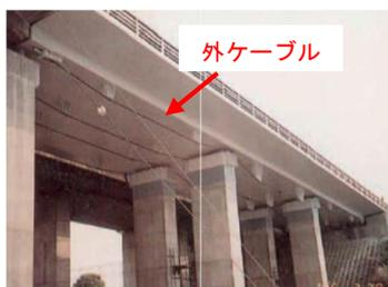
コンクリート橋の外ケーブル補強の例
