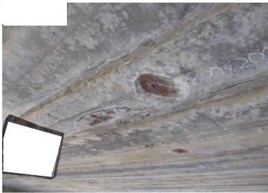
※写真はPC桁下面の損傷事例
