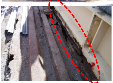
※ 舗装を除去した後の地覆の状態
