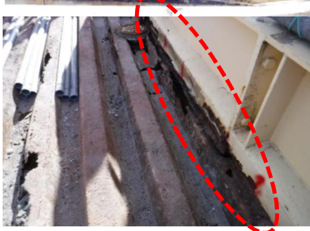
※ 舗装を除去した後の地覆の状態
