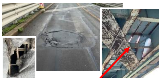
踏み抜き部分を はつり落とした後の床版下面の状況
