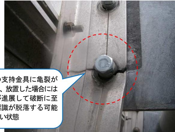
標識の支持金具が破断し、標識が脱落して被害をおよぼす可能性がある状態の例
