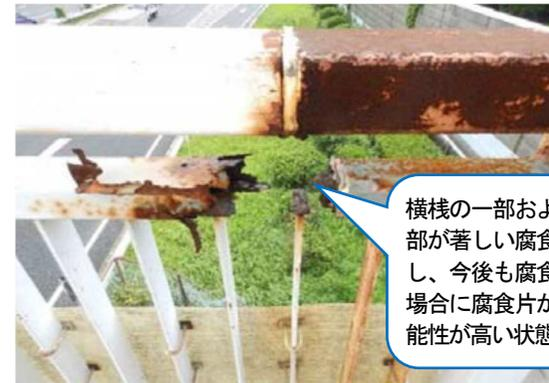
高欄の一部が落下して被害をおよぼす(した)可能性がある状態の例
