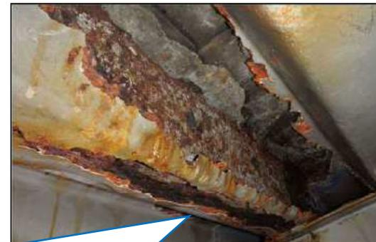
床版の一部が落下して甚大な被害をおよぼす可能性がある状態の例
