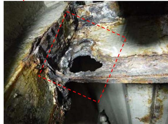
要素どうしの接合部の応力伝達機構の喪失が疑われる状態の例
