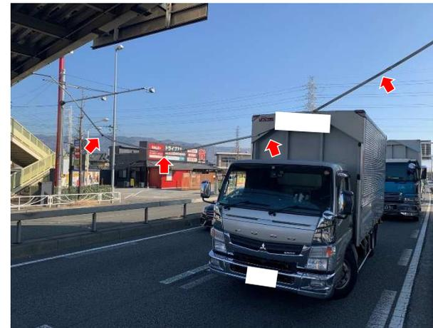
添架管が垂れ下がり建築限界へ抵触した状態の例
