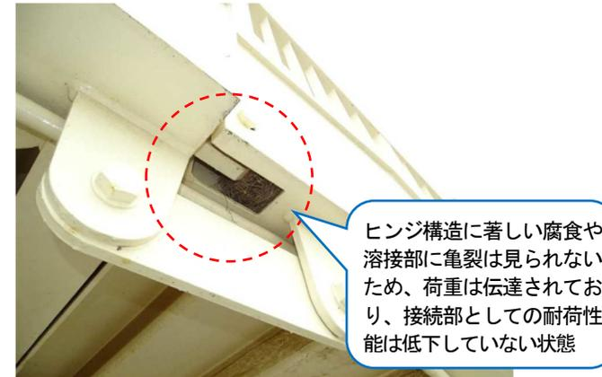
ヒンジ構造を有する接合部が荷重を伝達できる状態の例
