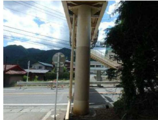
変位や変形が見られず作用への抵抗が低下していない状態の例
