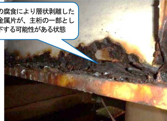
主桁の一部が落下して被害をおよぼす可能性がある状態の例
