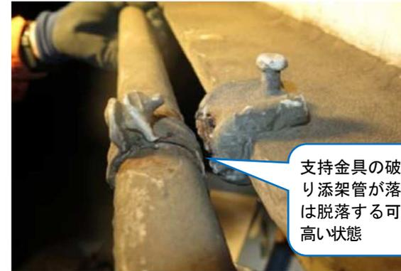
添架管の支持金具が破断し、添架管の垂れ下がりにより被害をおよぼす可能性がある状態の例
