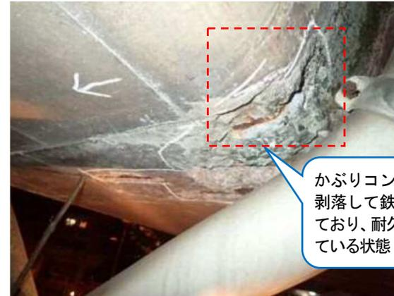
かぶりコンクリートが剥落して鉄筋が腐食しており、耐久性は低下している状態
