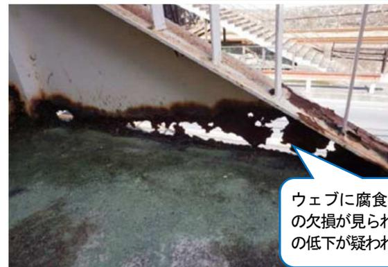
ウェブに腐食による断面の欠損が見られ、耐荷性能の低下が疑われる状態
