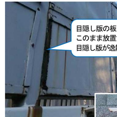
目隠し版の板に腐食や錆汁が見られ、このまま放置すると枠の脱落等により目隠し版が逸散する可能性がある状態
