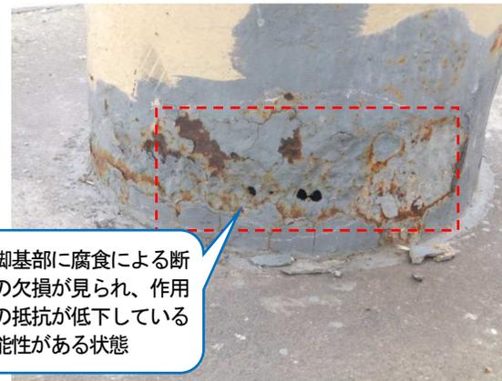
断面の欠損により作用への抵抗の低下が疑われる状態の例
