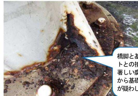
橋脚と基礎ベースプレートとの接合部に局部的に著しい腐食が見られ橋脚から基礎への応力の伝達が疑わしい状態
