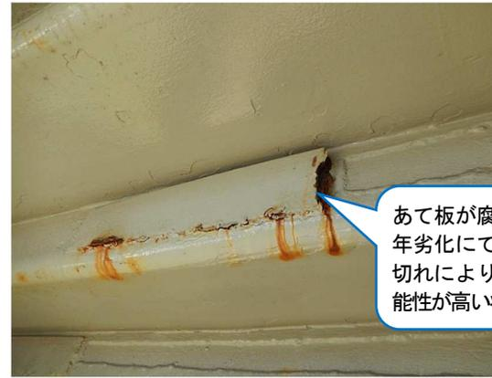
あて板が腐食または経年劣化にて変形し付着切れにより落下する可能性が高い状態
