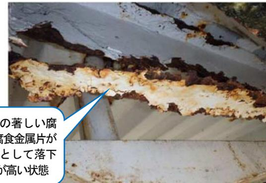
横桁の一部が落下して被害をおよぼす可能性がある状態の例
