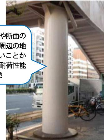
橋脚として変位、変形や断面の欠損が見られず、橋脚周辺の地盤の変状も見られないことから、下部構造としての耐荷性能は低下していない状態
