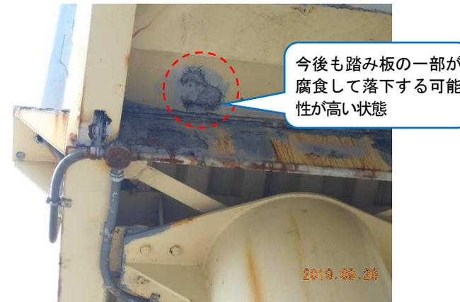
踏み板の一部が落下して被害をおよぼす可能性がある状態の例
