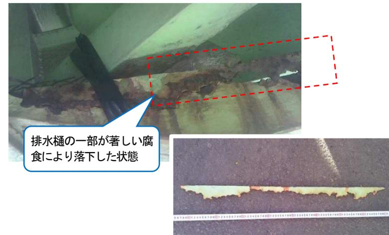
排水樋の一部が落下した状態の例
