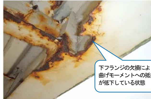
下フランジの欠損により曲げモーメントへの抵抗の低下が疑われる状態の例
