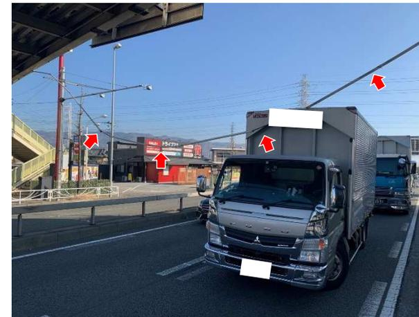
添架管が垂れ下がり通行車両へ被害をおよぼした例
