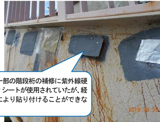
階段桁の補修材の一部が落下して被害をおよぼす可能性がある状態の例
