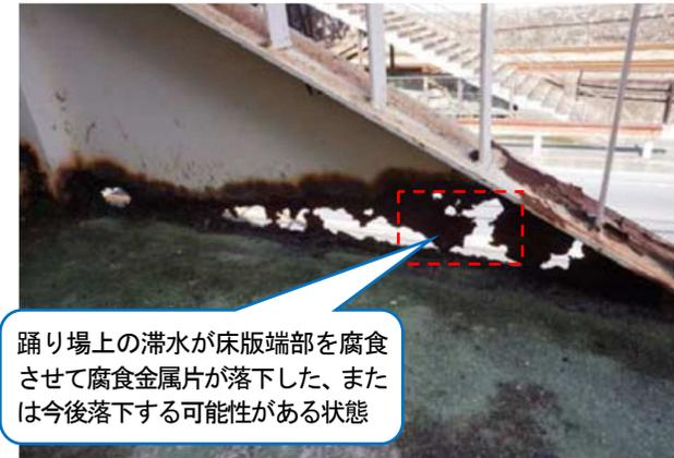
階段桁の一部が落下して被害をおよぼす可能性がある状態の例
