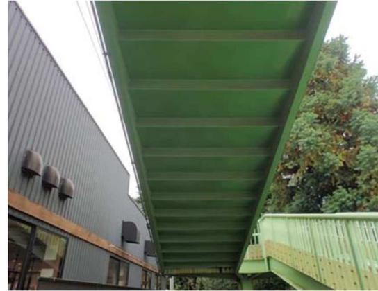
変位や変形が見られず作用に対する抵抗が低下していない状態の例
