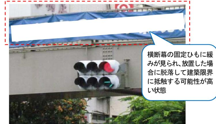
横断幕が外れて建築限界に抵触する可能性がある状態の例
