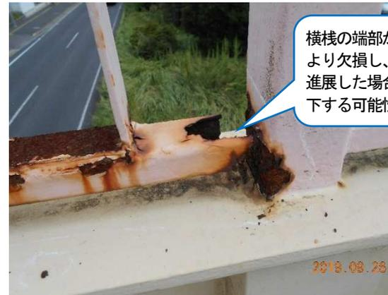
横棧の端部が著しい腐食により欠損し、今後も腐食が進展した場合に腐食片が落下する可能性が高い状態
