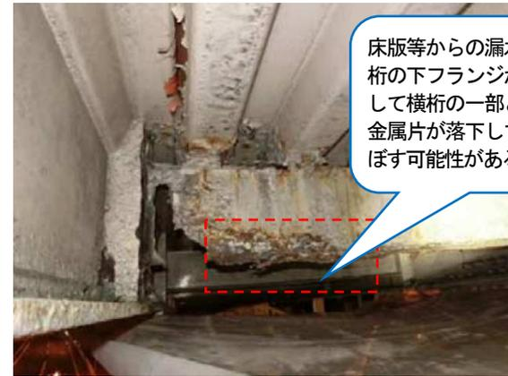
横桁の一部が落下して被害をおよぼす可能性がある状態の例
