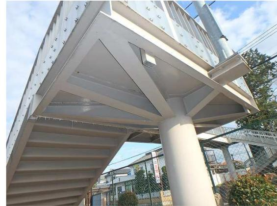
変位や変形が見られず作用への抵抗の低下がしていない状態の例
