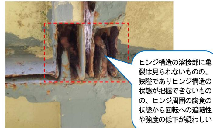
ヒンジ構造を有する接合部の腐食により回転への追従性や強度の低下が疑わしい状態の例
