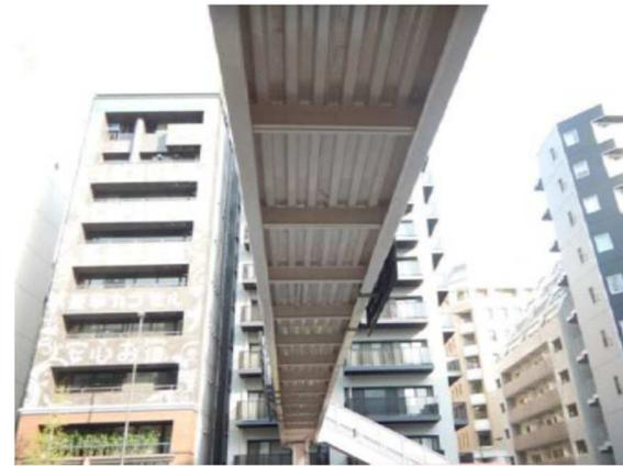
上部構造として耐荷性能が低下していない状態の例
