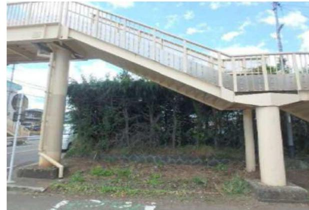
上部構造(階段)として耐荷性能が低下していない状態の例
