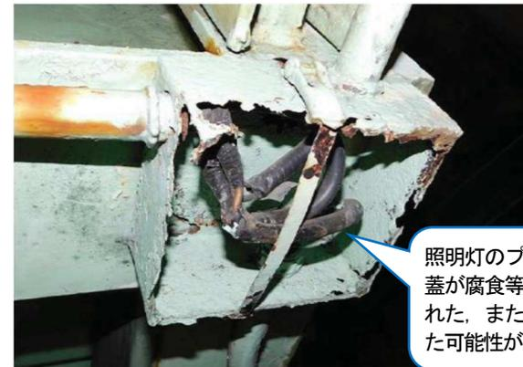
照明灯のプルボックスの蓋が落下して被害をおよぼした可能性がある状態の例
