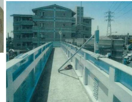
照明灯の溶接部に亀裂が生じて転倒した例
