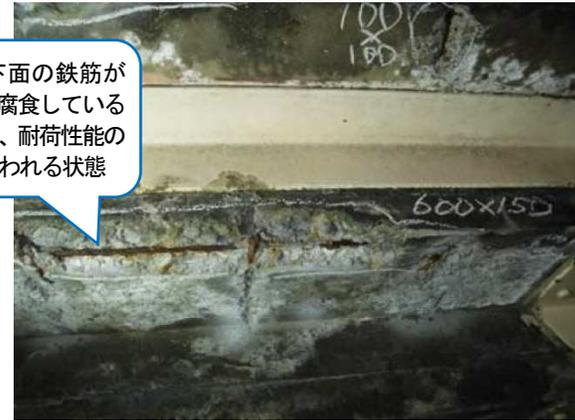
コンクリート製の踏み板の鉄筋の腐食により作用への抵抗の低下が
