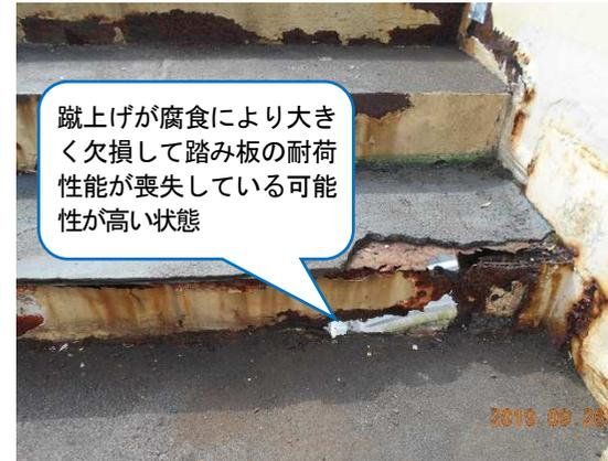
蹴上げの欠損により作用に対する抵抗の著しい低下が疑われる状態の例
