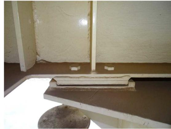
上部構造から下部構造へ荷重を伝達できる状態
