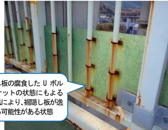
裾隠し板の腐食した U ボルトやナットの状態にもよるが強風により、裾隠し板が逸散する可能性がある状態
