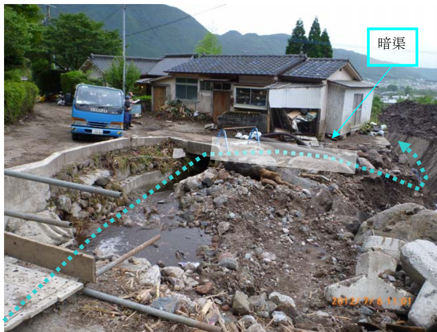
写真 6 2号えん堤下流の溪流保全工。幅約4m、高さは約3m程度。水路勾配は6~8°。水路は右岸へ湾曲しており、土石流は湾曲部で左岸側に一部氾濫していた。
