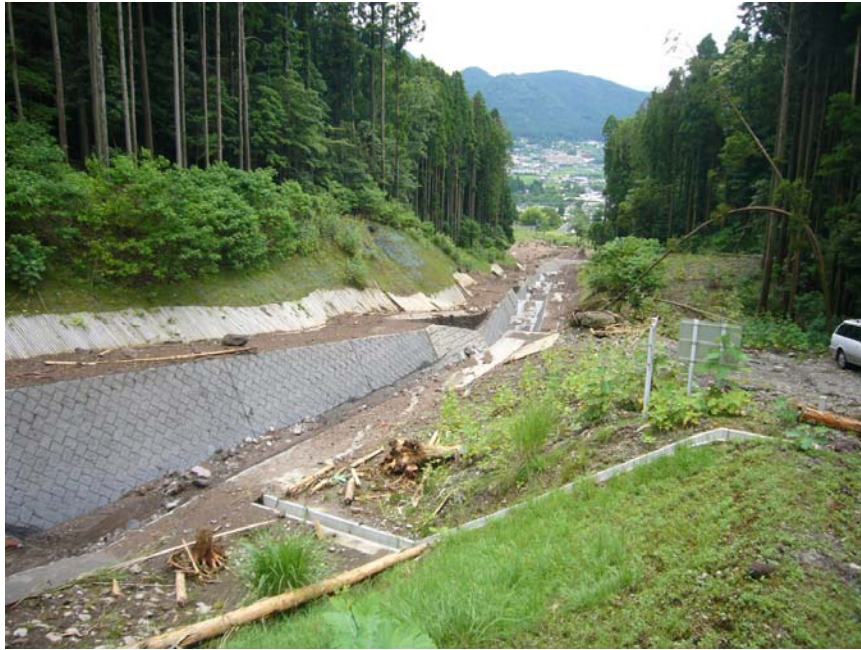
写真 6 2号えん堤下流の溪流保全工。幅約4m、高さは約3m程度。水路勾配は6~8°。水路は右岸へ湾曲しており、土石流は湾曲部で左岸側に一部氾濫していた。
