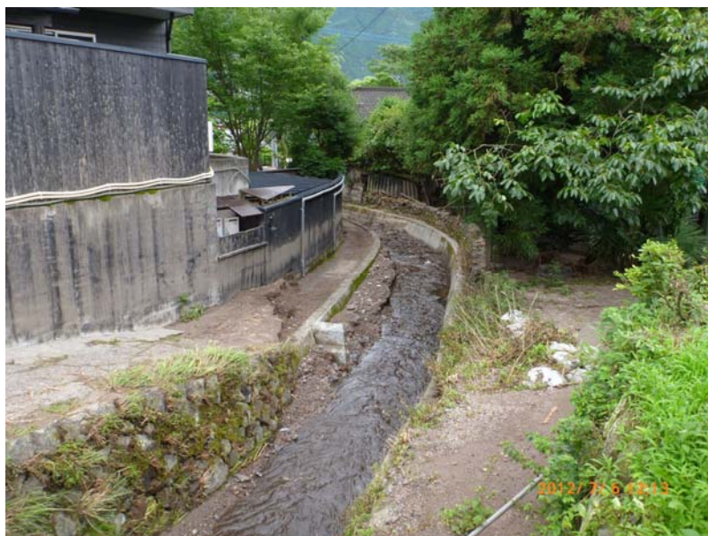
写真 8 県道 216 号から上流部にある家屋。大きな流木は確認できなかった、1m程度の巨礫がひとつ確認できたが、主要な粒径は数 10cm 程度であった。
