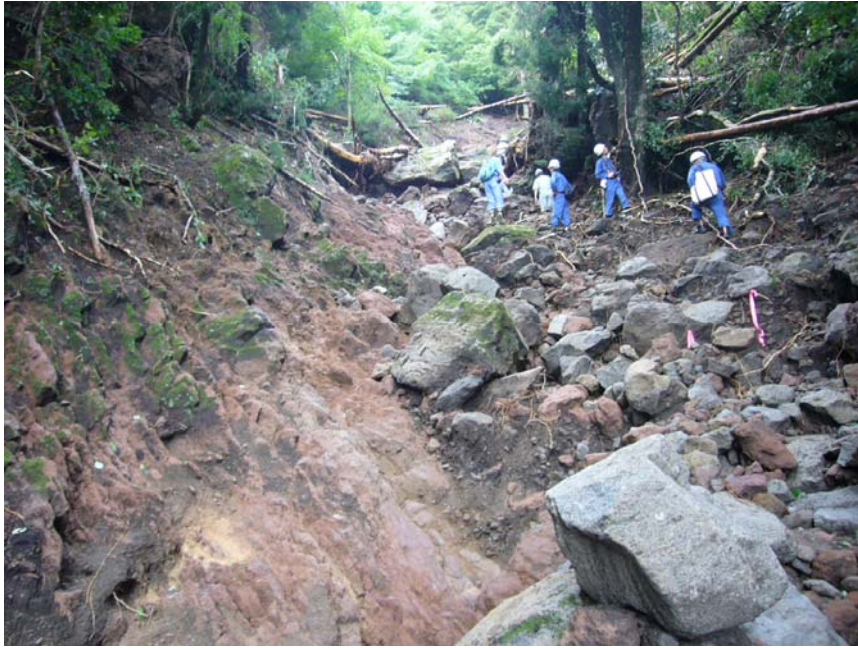
写真 2 岳本川の土石流発生箇所の上流部。上流部に崩壊地は確認できなかった。
