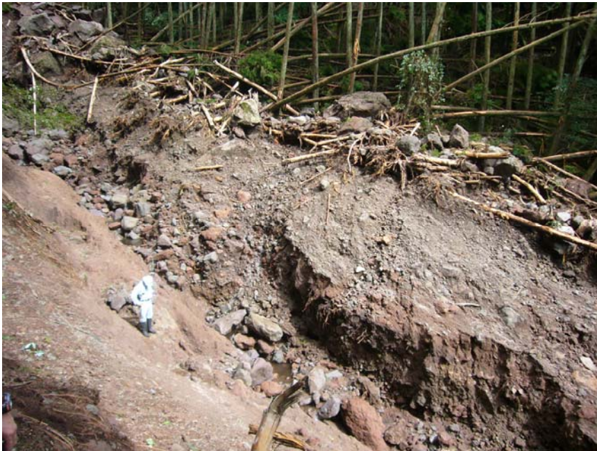
写真 3 岳本川の土石流発生箇所の下流部。河床が顕著に侵食されており、溪岸上部に流木（倒木含む）がいたるところで確認できた。
