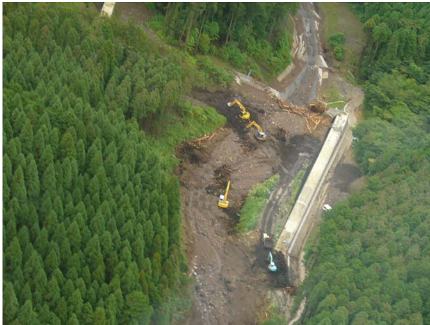
写真5 2号砂防えん堤をヘリから望む。除石作業中
