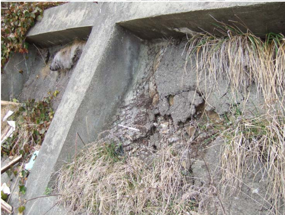
堀切山南側斜面の法枠
