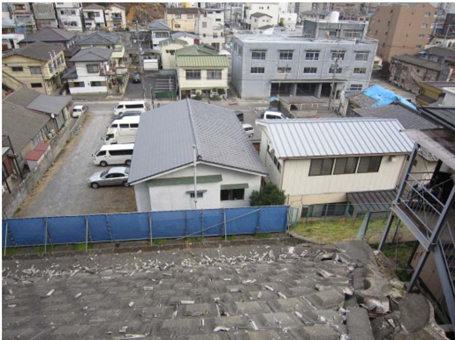
②斜面上端から斜面下方をのぞむ（のり砕工の破片が散乱している）
