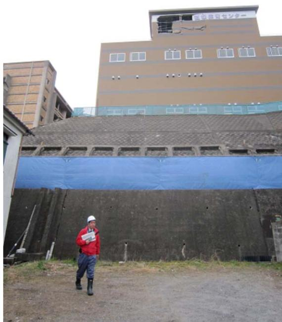
⑥擁壁工、のり砕工、積ブロック（擁壁に特に異常は見られず）
