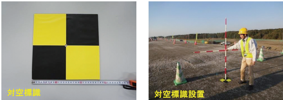
図7 標定点・検証点設置の様子
