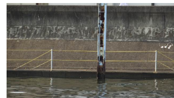
図-11 試験フィールドのコンクリート護岸
