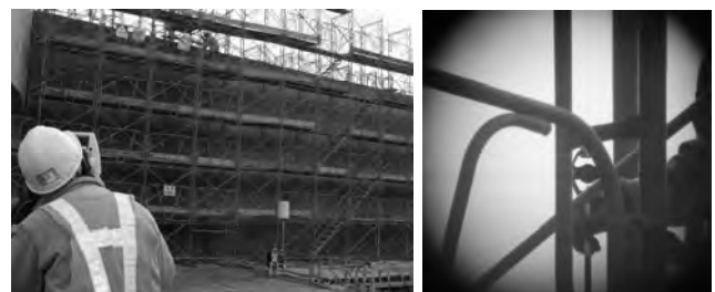
写真-3 TSで計測する際の足場との見通状況
