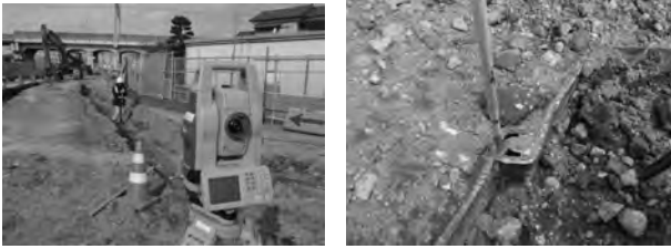
写真-1 TSによる計測点（土留工（鋼矢板））
