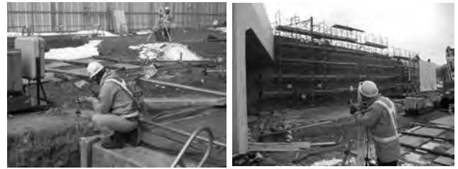
写真-2 TSによる計測点（擁壁工）
