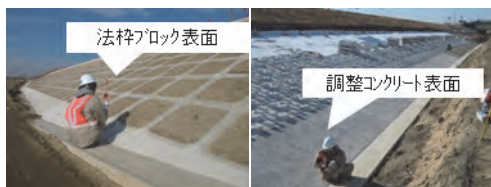
写真-1 TSによる計測点（法尻側）
