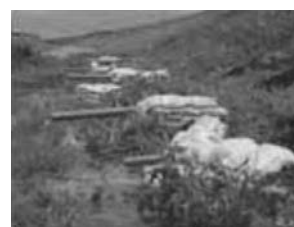
河川堤防の漏水
