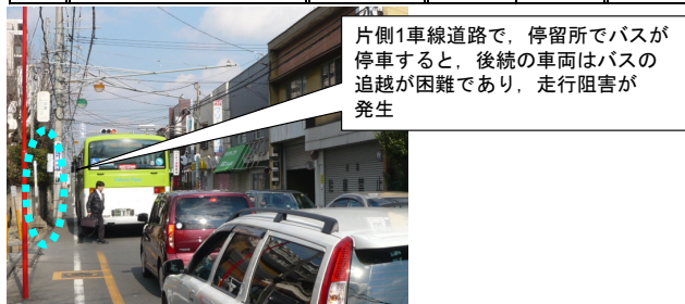
図-8 走行阻害発生率の高い太田窪停留所の状況
