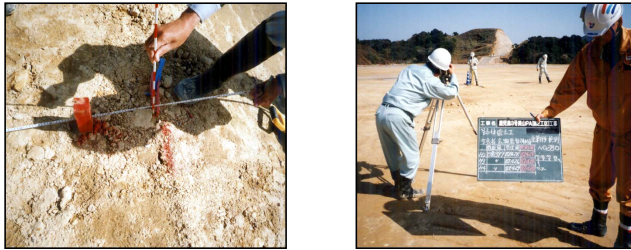
幅員計測状況(巻尺) 高さ計測状況(レベル)
