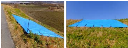
図-6 対象物の設置の様子
