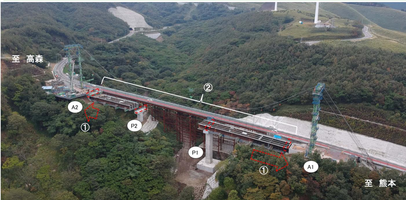
桁の架設が進む俵山大橋
