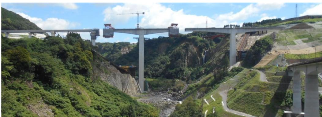
橋桁の端部が橋脚上にもない状態でも橋桁が落ちない状態を保っている新阿蘇大橋(施工中)
