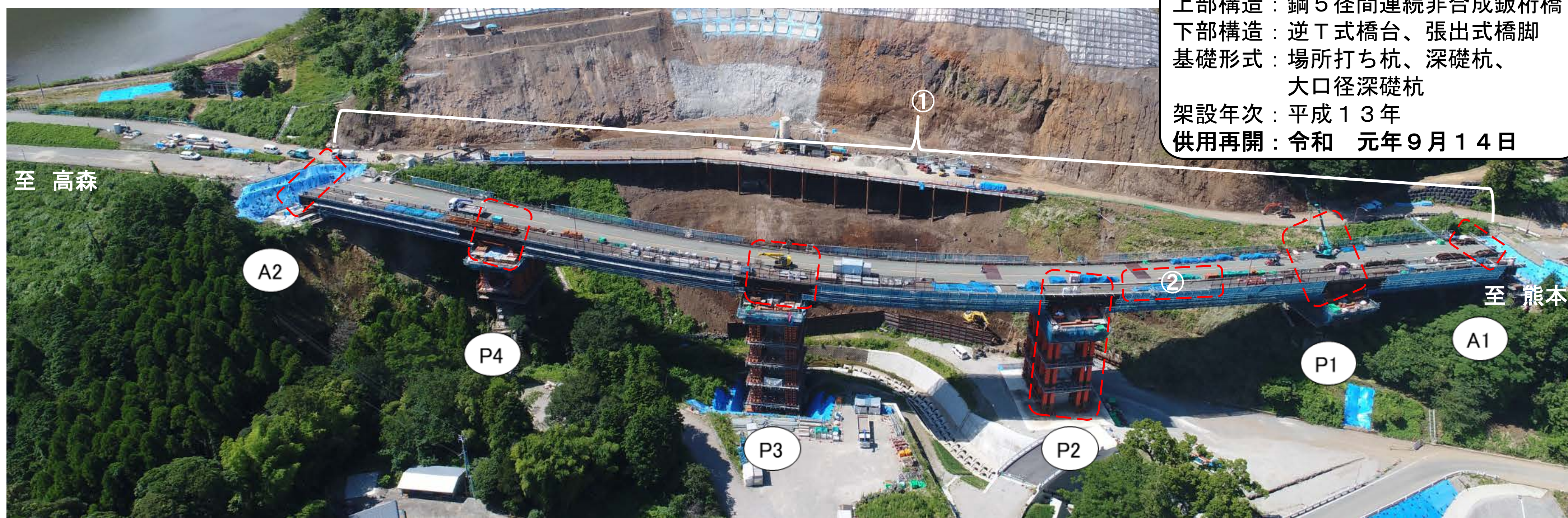
ジャッキアップ中の大切畑大橋
