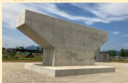
▼ 橋脚出来形模型
