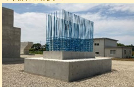
▼ 橋脚配筋模型
