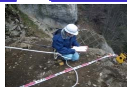
高所斜面上の臨場検査
