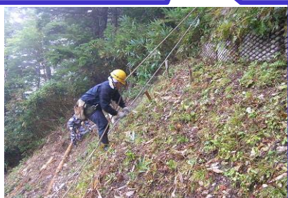
斜面上の測量作業
