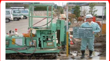
薬液注入状況
