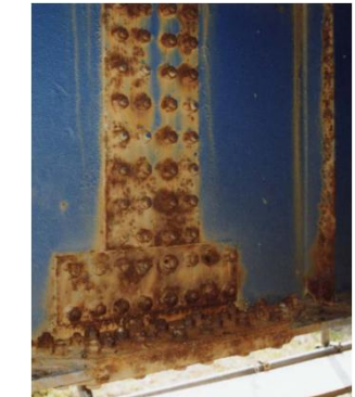
現場継手部の腐食事例
