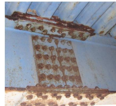
現場継手部の腐食事例
