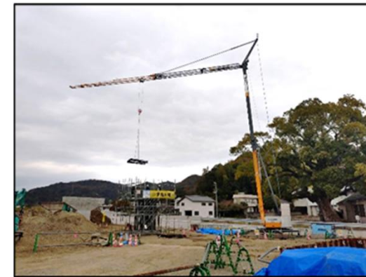
定置式水平ジブクレーンの活用 (クレーンは常設いつでも使える。 操作は技能者が自らリモコンを用いて実施)
