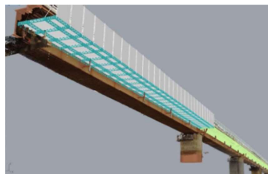
写真-3 新飯野川橋
