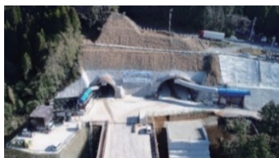
図-7 二重峠トンネル
