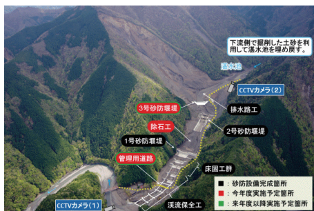
図－12 赤谷地区砂防設備
