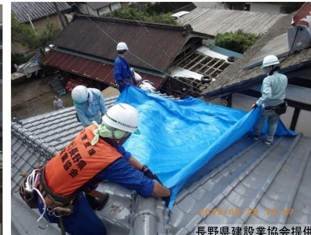
ブルーシートによる屋根瓦の補修
