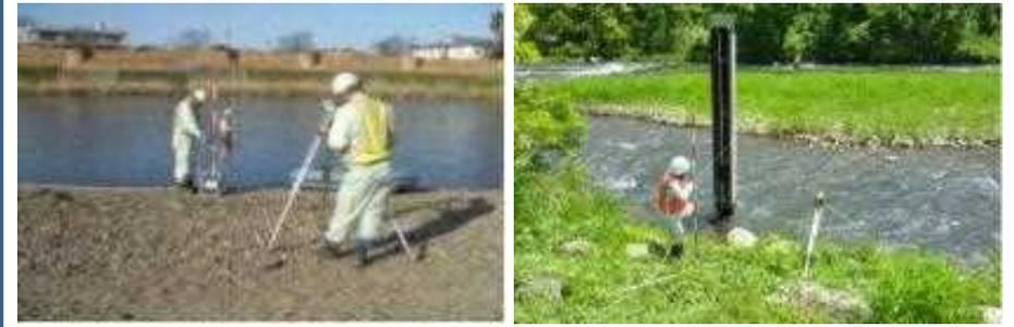
堤防点検（堤防の変状（亀裂、法崩れ等）把握）
