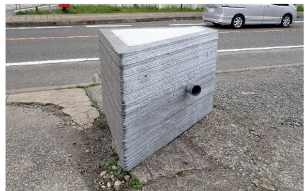
図-4.7 重力式擁壁 (現地据付前)
