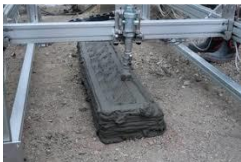
図-3.1 施工状況 (写真提供: 京都国道事務所)
