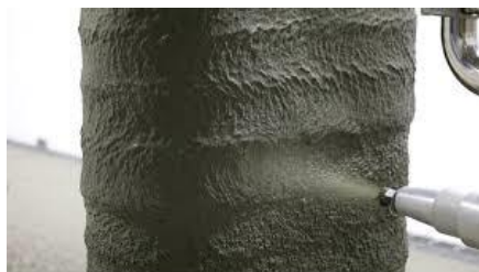
図-2.4 材料噴射方式 (写真提供: 清水建設)
