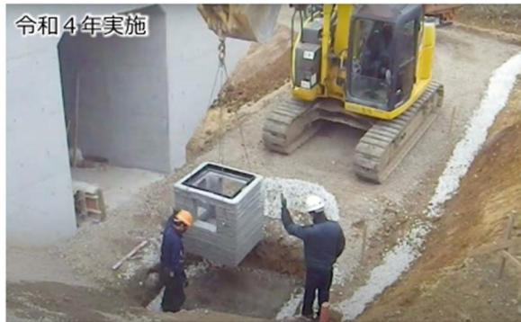
図-4.4 集水ます (国内の公共工事での初施工)
