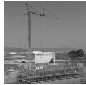
図-1 ジブクレーンの例
