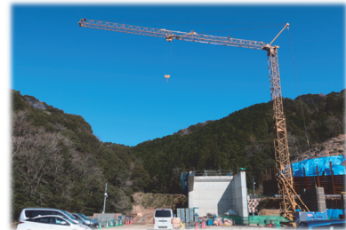
図-6 定置式水平ジブクレーン
