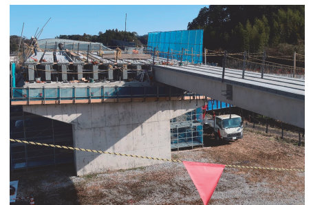
橋梁上部（床版・横組工）
