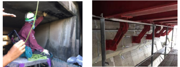
写真-1 狭隘な作業空間における橋梁補修工事
