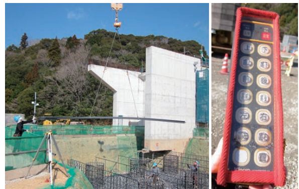
写真-5 クレーンの操作状況と操作リモコン
