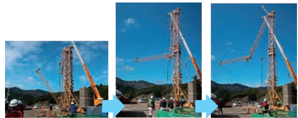
写真-4 定置式水平ジブの立ち上げ状況
