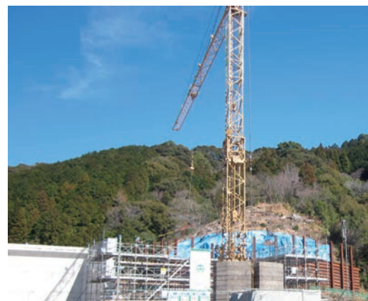
写真-9 定置式水平ジブクレーンによる作業状況
