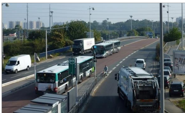
③一般車線と物理的に分離したバスレーン （パリ TVM, フランス）
