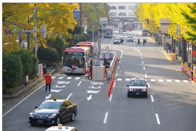
BRT 等のさらなる機能向上を目指し、道路中央部の専用走行路と路上バス停の設置の検討を進める中で、路上バス停の社会実験を実施し、改善点の確認や周辺交通への影響を検証
