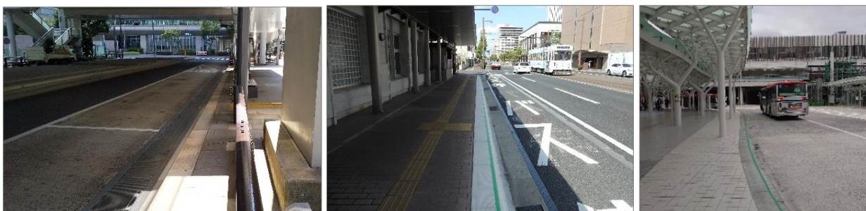
⑦国内におけるバス停留所のバリアレス縁石の整備事例 （東京 BRT 新橋バス停／岡山市表町バスセンター／新潟駅バスターミナル）
