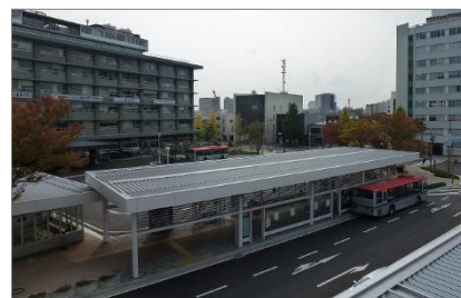
図 6-3 道路区域に設置した交通結節点
