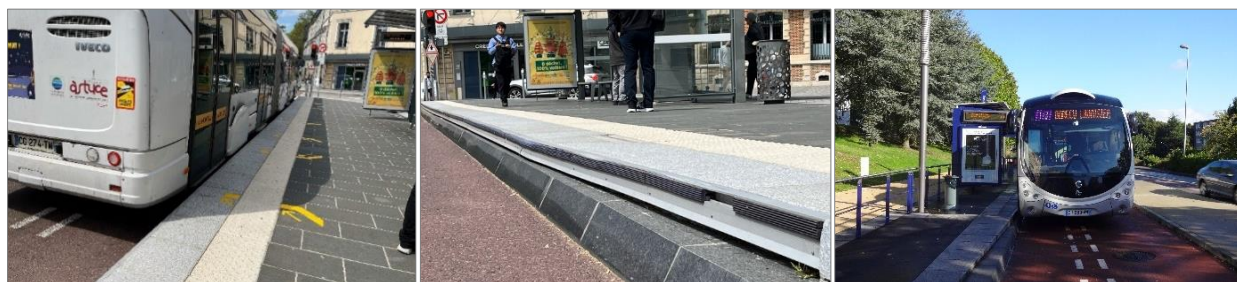
自動操舵によるバス停車システム（乗務員はハンドル操作不要で速度のみをコントロール）（ルーアン）
