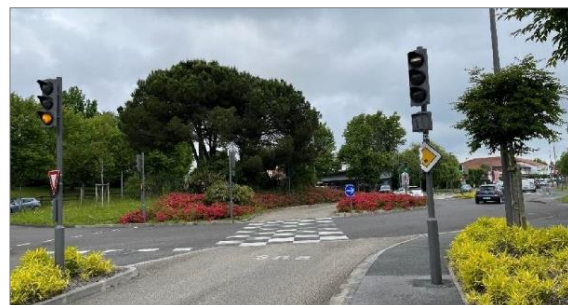
図 4-15 ラウンドアバウト中心部を通過する専用レーン (バイヨンヌ, フランス)
