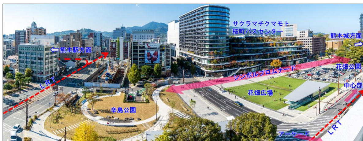
図 1-18 バスセンターと隣接する「くまもと街なか広場（花畑広場）」
