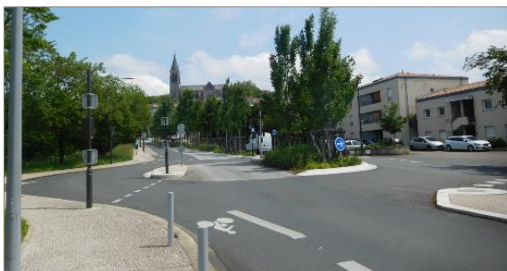
図 4-15 ラウンドアバウト中心部を通過する専用レーン (バイヨンヌ, フランス)
