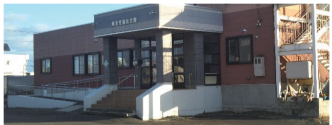
写真3 札幌市の災害危険区域における建物基礎の嵩上げ
