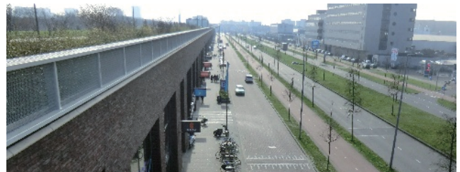
写真1 オランダ・ロッテルダム市における堤防を兼ねた公園(上部)・店舗(下部)の整備
