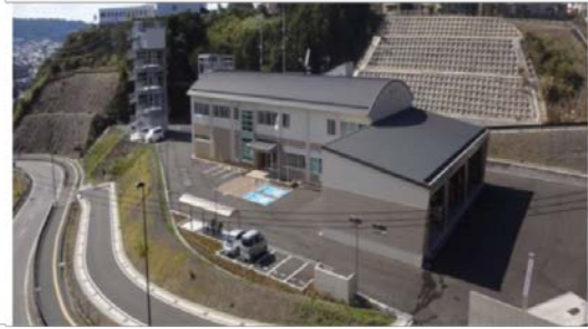
高台移転した消防防災センター(消防署)
