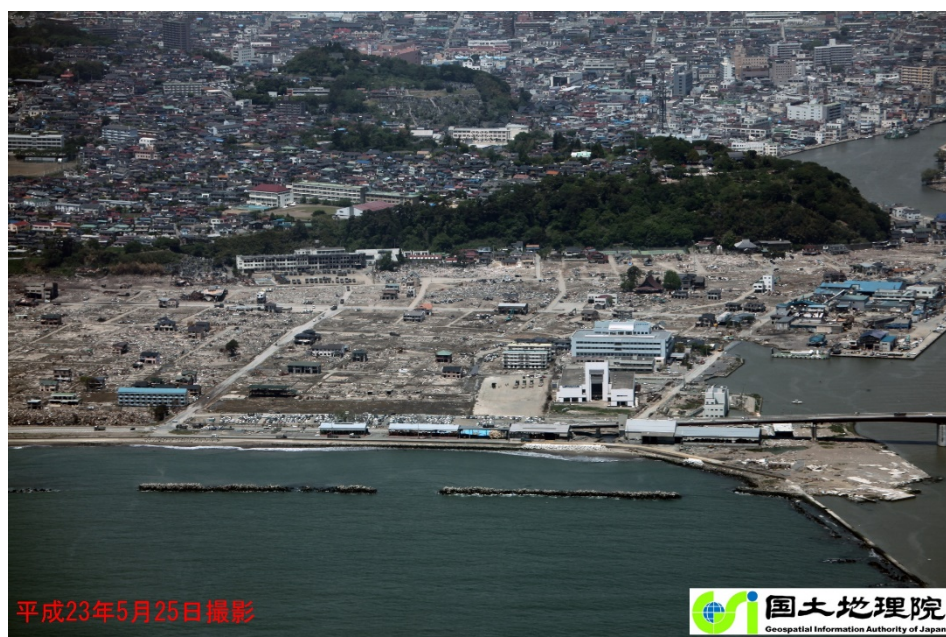
写真 1 東日本大震災における津波浸水被害（宮城県石巻市門脇地区）
