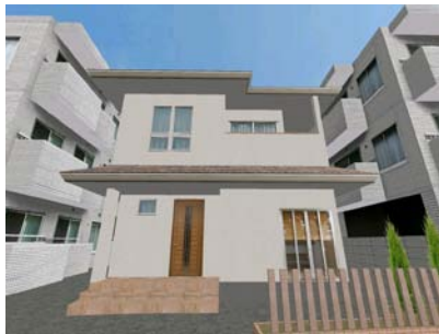
両側隣地にマンション 3階
