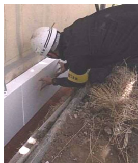
外壁の断熱化工事
