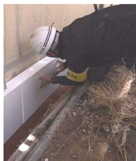
外壁の断熱化工事
