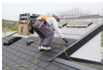
屋根の断熱化工事
