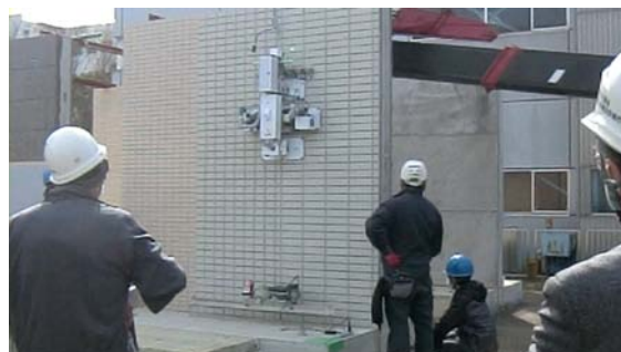
写真9 平成25年3月26日に実施した実証実験の様子(2)
