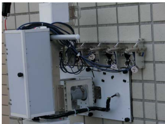
写真3 打音装置の取り付け状況
