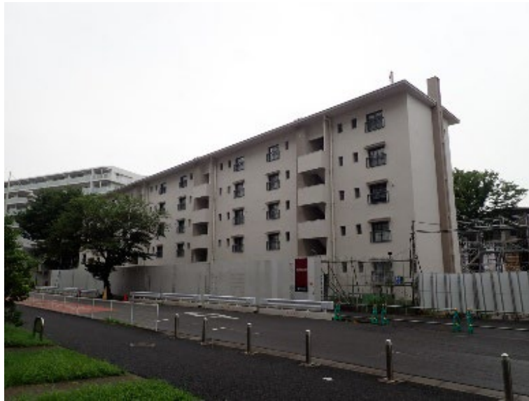
図②-18 設置対象箇所(UR 赤羽台 41 号棟)
