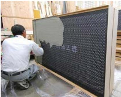
写真 3.8.3 モルタルの施工
