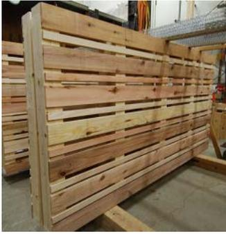
写真 3.8.1 二層下地通気構法のラス下地板
