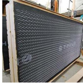
写真 3.8.2 アスファルトフェルトおよび波形ラスの施工
